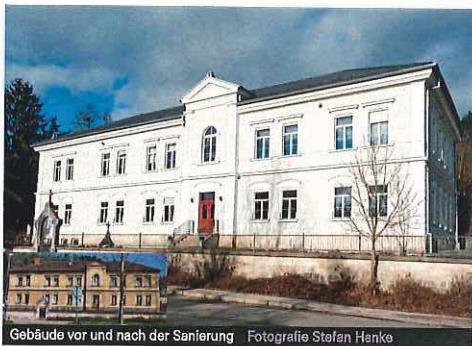
Gebäude vor und nach der Sanierung Fotografie Stefan Hanke
