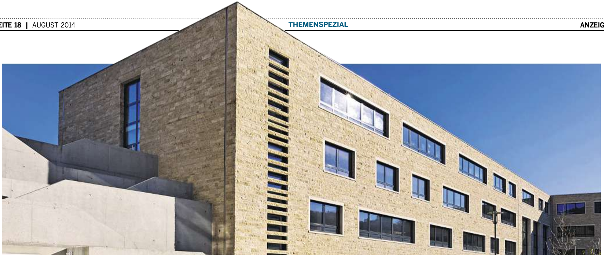
Beim Neubau und der teilweisen Sanierung der Realschule Riedenburg (Landkreis Kelheim) verbanden Norbert Raith und sein Team unter anderem mit der einzigartigen Natursteinfassade Ästhetik mit Nachhaltigkeit.
