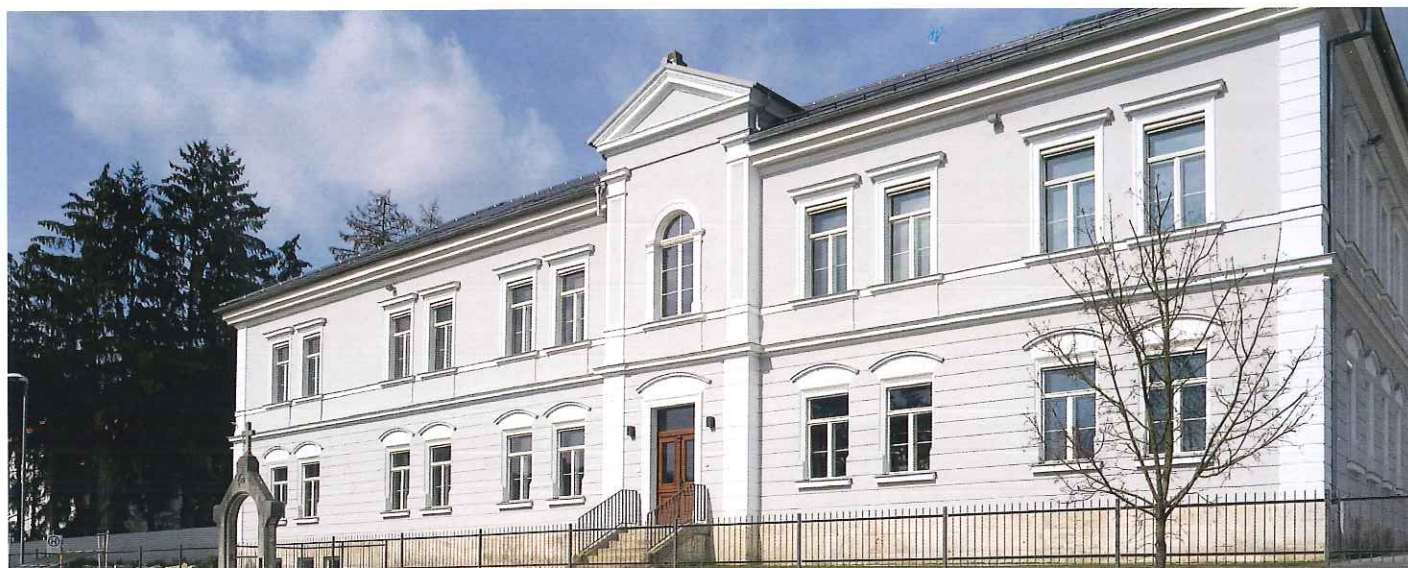
Erst gemeinsames Projekt, dann gemeinsame Heimat: der denkmalgeschützte Firmensitz in der Riedenburg Straße
